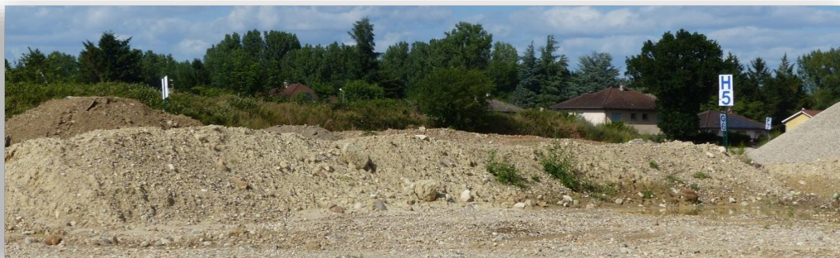
Système de quadrillage des matériaux inertes utilisés pour le remblaiement
