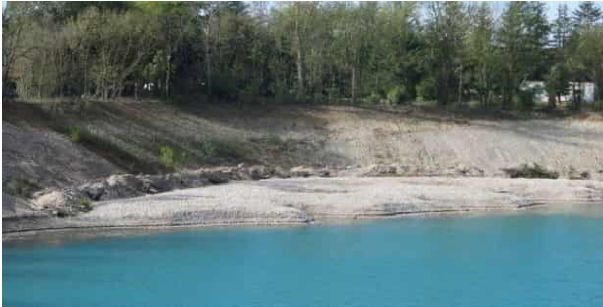
Exemple de plages créées (Anses irrégulières, forte épaisseur de gravier, mares pour crapaud calamite).
