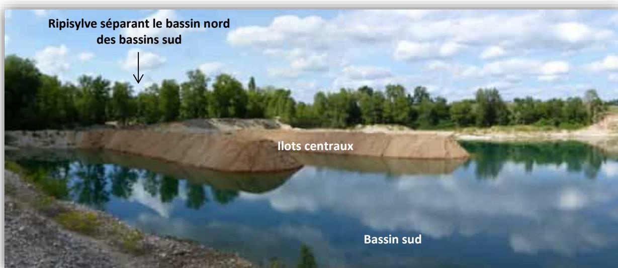
Carrière de Saint-Romain-de-Jalions : îlots centraux au nord du bassin sud (en cours de réalisation : depuis la réalisation de la photographie, les berges ont été adoucies et les plages de galets réalisées)
