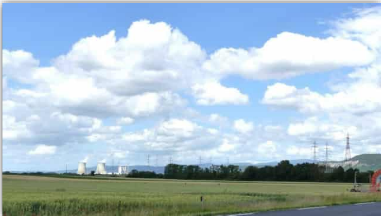
Ligne Très Haute Tension et Centrale nucléaire du Bugey
