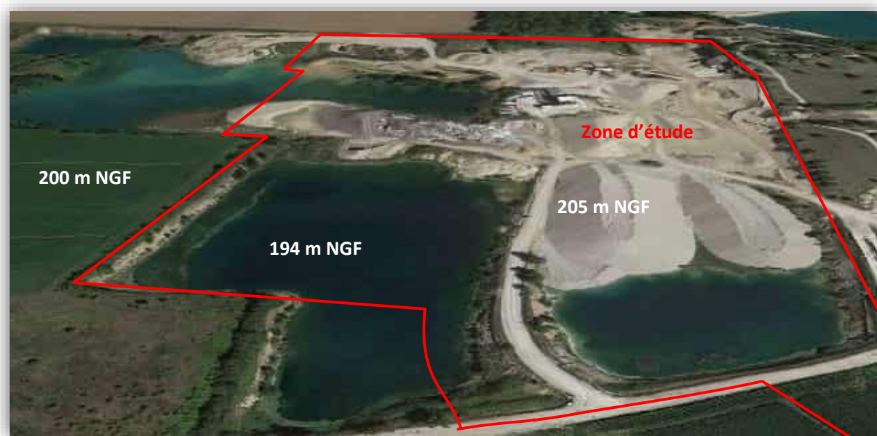
Vue aérienne de la carrière de Tignieu (source : Google Earth)
