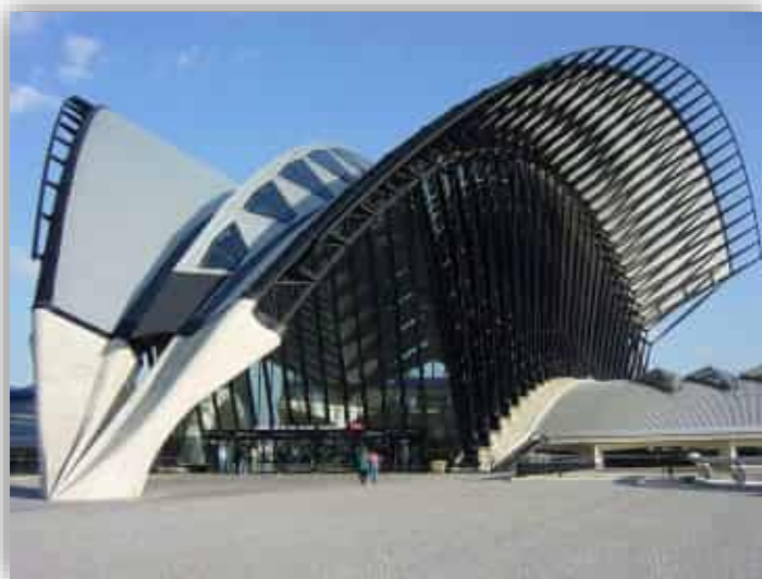
Gare TGV Lyon-Saint-Exupéry
