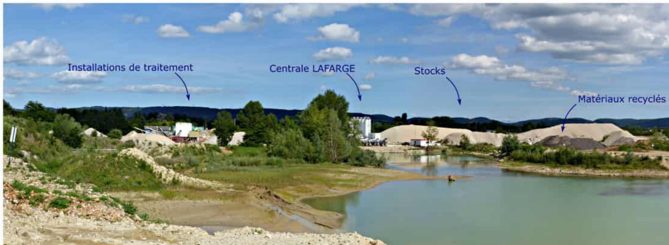
Vue E : Vue vers le sud-est sur la carrière avec les installations de concassage-criblage, la centrale à béton LAFARGE, les stocks de matériaux extraits et les stocks de matériaux recyclés ainsi que l'étendue d'eau au droit de l'ancienne zone d'exploitation.
