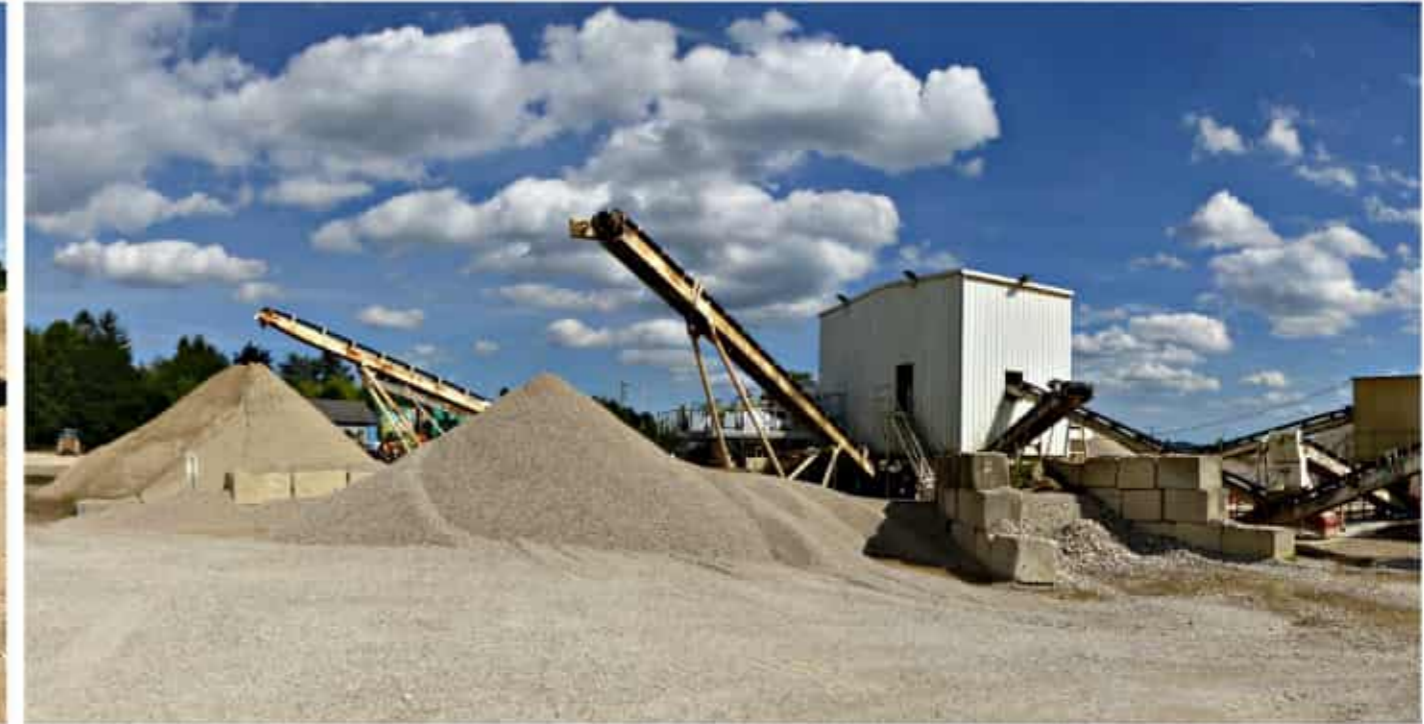
Vue D : Installations de concassage-criblage et stocks associés
