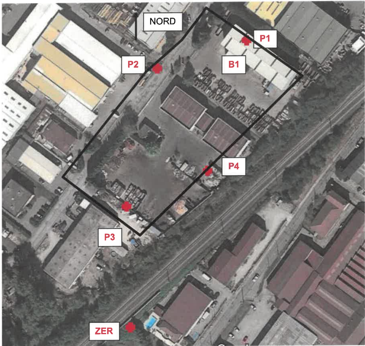
Figure 60 : Emplacement des points de mesures sur le site d'ARC-EN-CIEL Recyclage (source : Google MAPS)
