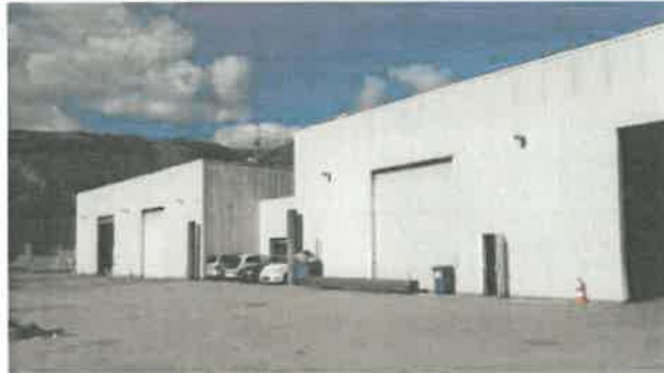
Figure 5 : Bâtiment « Stockage Métaux »
