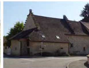
Toit à Mantelures
