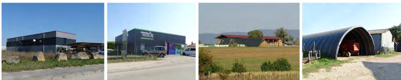
HANGARS ET ZONES D'ACTIVITÉS : profitant de la proximité des grands axes de transports, les zones d'activités s'installent en périphérie des bourgs. Quelques hangars agricoles, impactant les ambiances agraires, témoignent néanmoins de la pérennité de l'agriculture.
