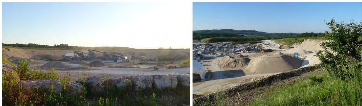
Zone d'exploitation des installations de traitement et valorisation des matériaux de Palenge
