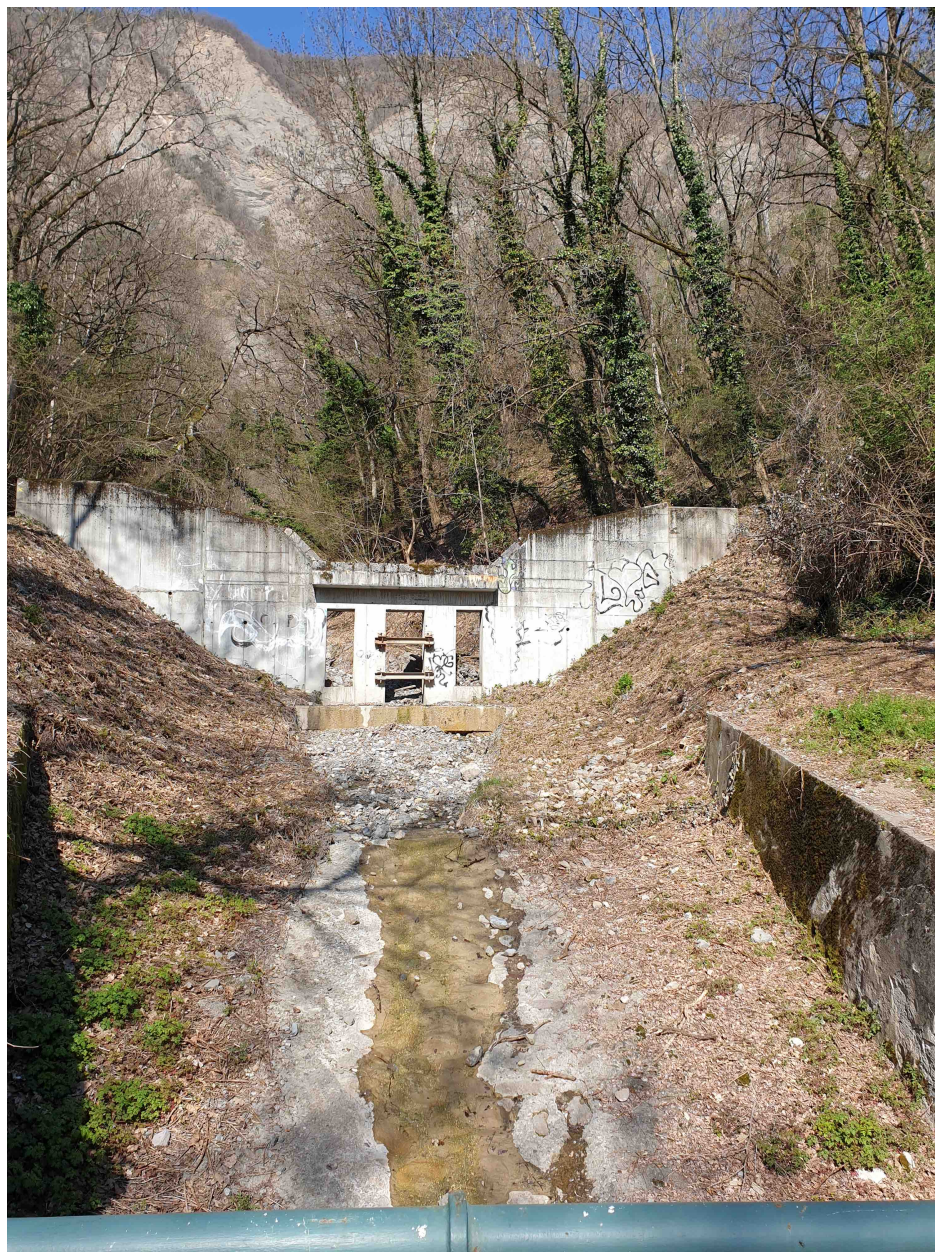
plage de dépôt et ouvrage RTM
