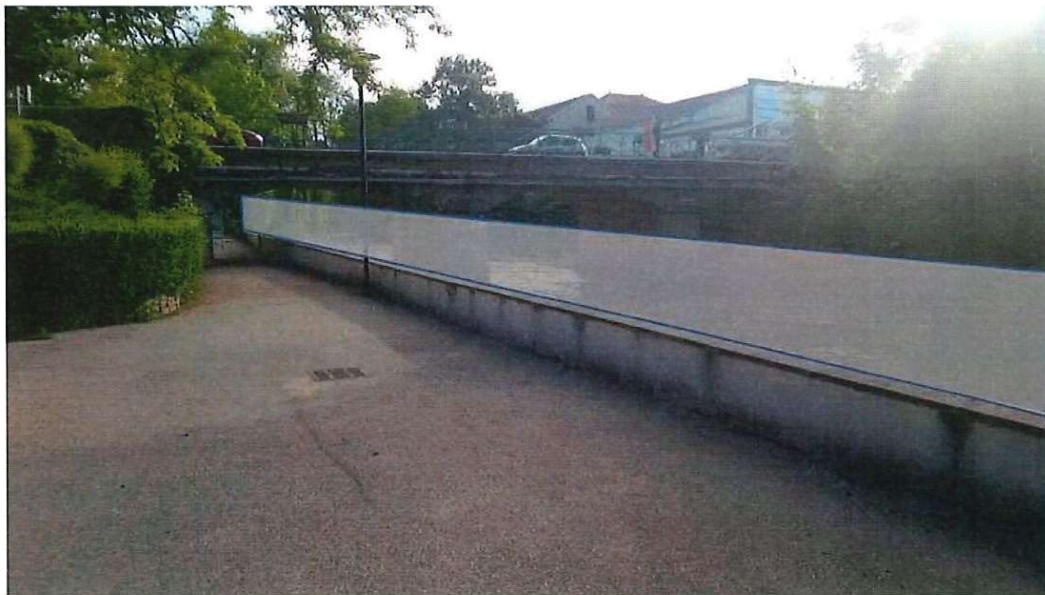
Vue sous la mairie et passage sous la RD517
