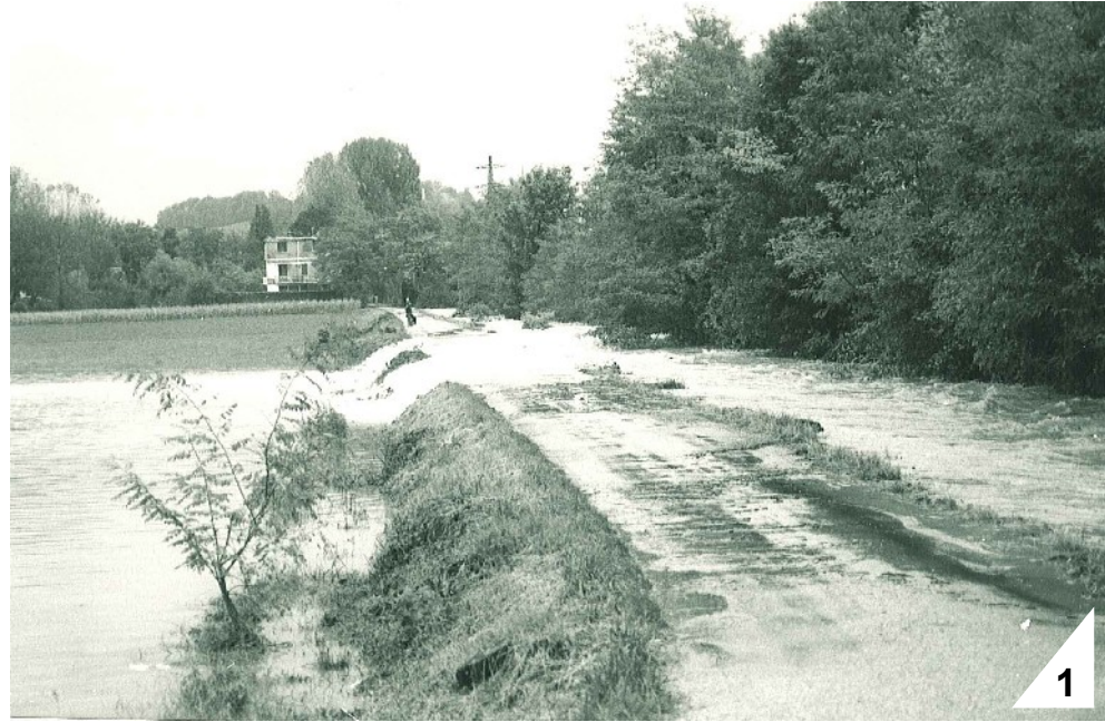
1 St Jean de Soudain : débordements de la Bourbre par dessus la digue rive droite, sans rupture, en amont de la RD 1.
