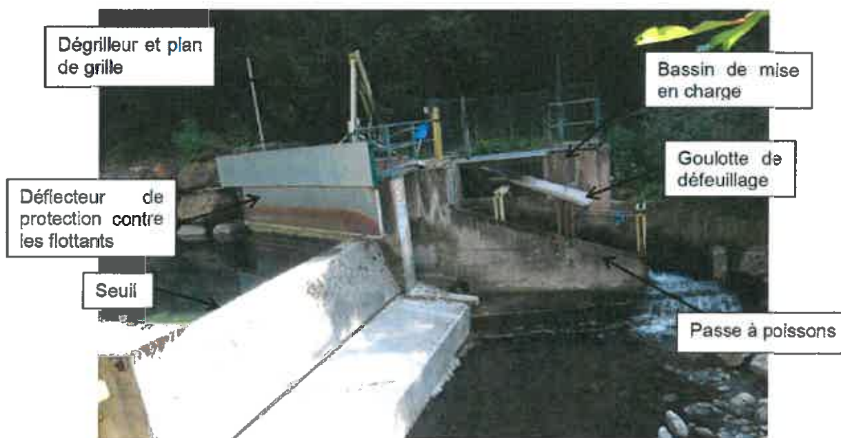
Vue générale de la prise d'eau
