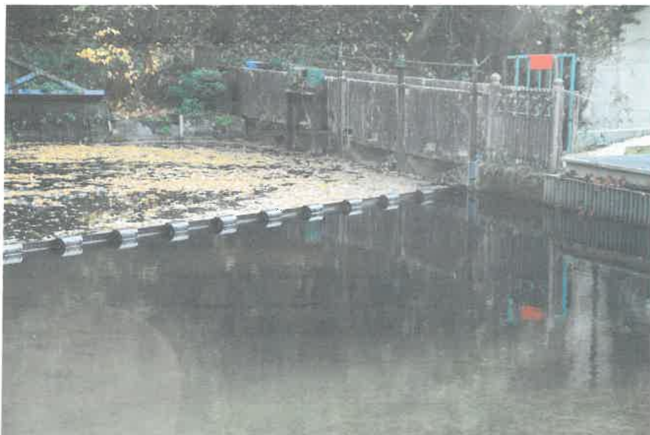
Papeterie de Renage Barrage alimentant la vis d'Archimède Séparation des déchets flottants - A droite entrée de la vis d'Archimède
