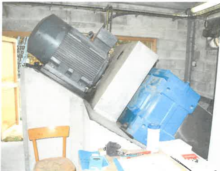
Papeterie de Renage – Alternateur de la Vis d'Archimède À droite, armoire de commande, régulation & surveillance, enregistrement production
