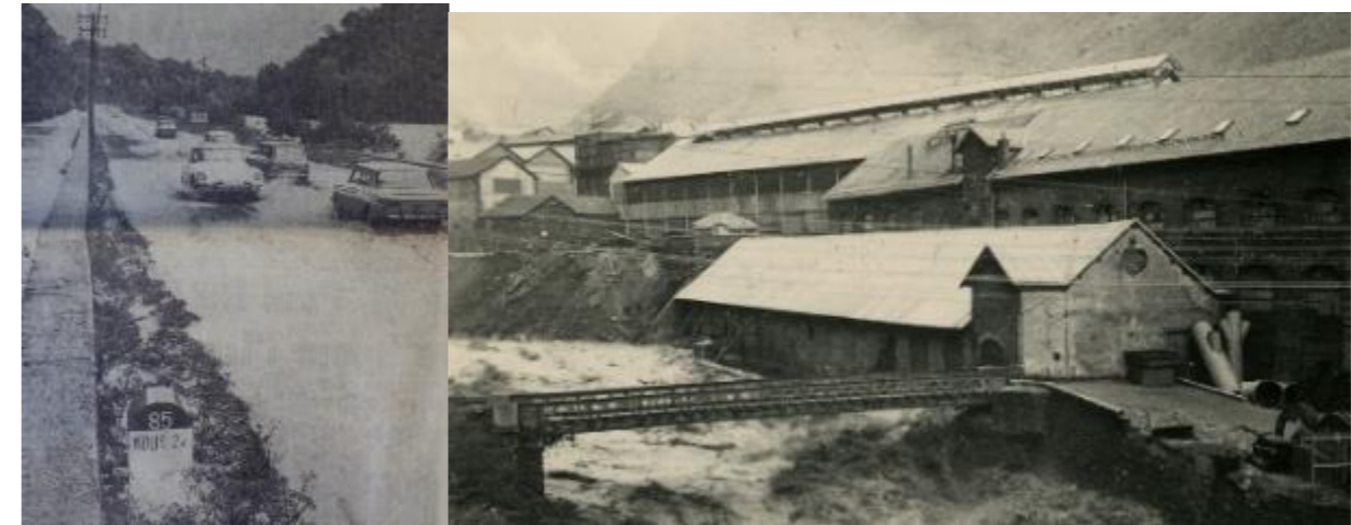
La RN 85 inondée lors de la crue de 1968 (à gauche) et crue de la Romanche de 1914 au niveau de la centrale EDF de Rioupéroux (à droite)
