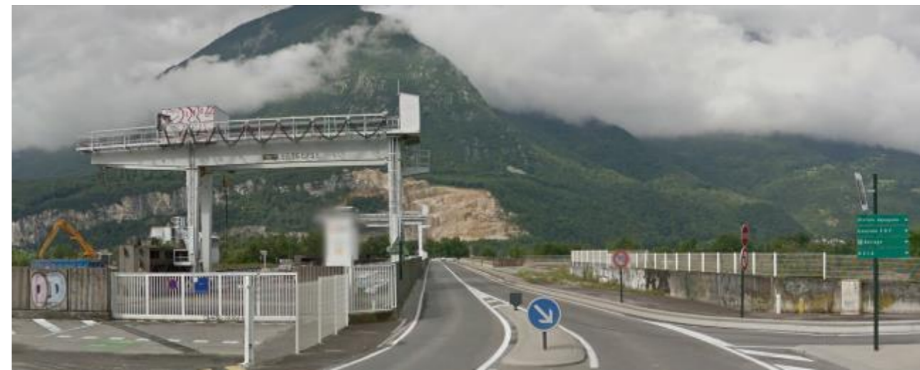
Centrale hydroélectrique de Saint-Egrève
