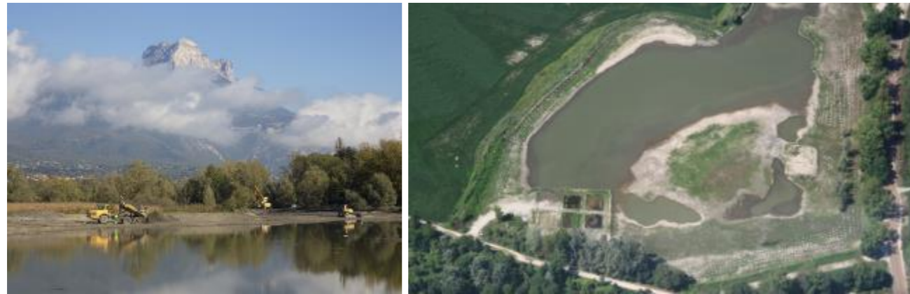
Travaux de renaturation du plan d'eau Pacific – 2015/2016 (Source : SYMBHI)
