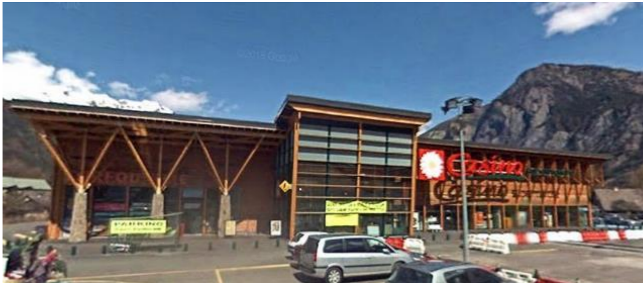
RD 1091 (en haut à gauche), déchetterie de Bourg d'Oisans (en haut à droite) et supermarché Casino (en bas)
