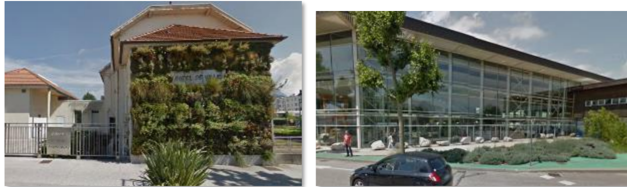
Mairie de Seyssinet-Pariset (à gauche) et espace Comboire (à gauche)
