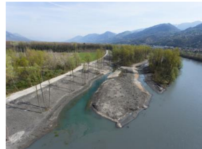
Reconnexion de bras secondaires à Pré Pichat (Source : SYMBHI)
