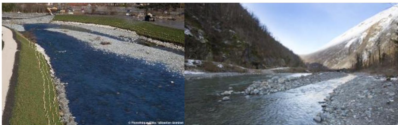
Le nouveau visage de la Romanche après les travaux d'aménagement du SYMBHI : à gauche, la traversée de Vizille – à droite, la plaine de l'Île Falcon
