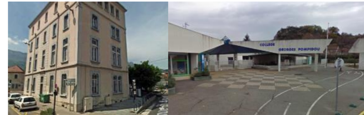
Mairie de Pont de Claix (à gauche) et collège Georges Pompidou à Claix (à droite)
