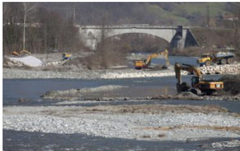
Travaux hydrauliques en amont du pont Napoléon (Source : SYMBHI)
