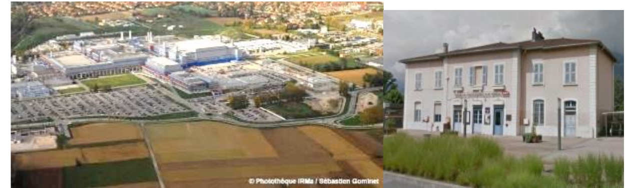
Site ST Microélectronique à Crolles (gauche) et gare de Pontcharra (droite)
