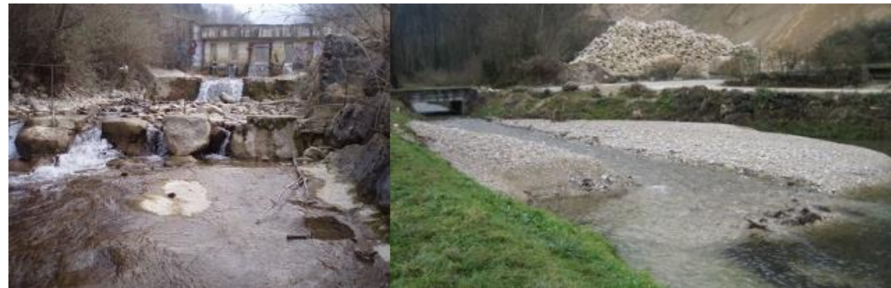
La Roize en aval du barrage de Voreppe (à gauche) et le Versoud (à droite)
