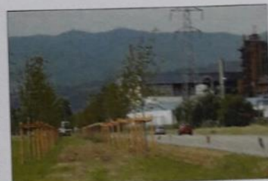
Les aménagements paysagers en cours sur la route reliant Salaise-sur-Sanne à Sablons. (L.D.A.)
