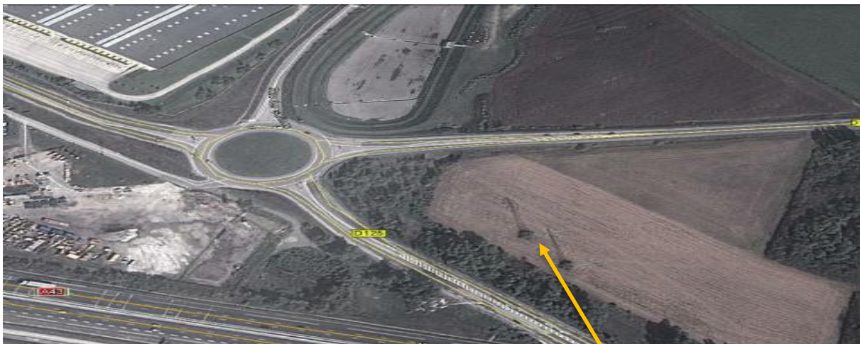
Le giratoire Ouest et les pylônes de la ligne ERDF THT
