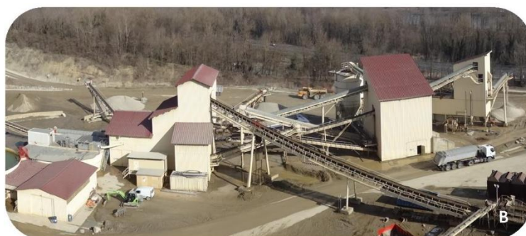
Illustrations de mesures visant à réduire les émissions sonores issues du site de Barraux. De gauche à droite : (A) Limitation de la vitesse de circulation à 20 km/h sur le site ; (B) Bardage de l'installation de traitement présente sur le site. Photo : 2015 - Granulats VICAT.
