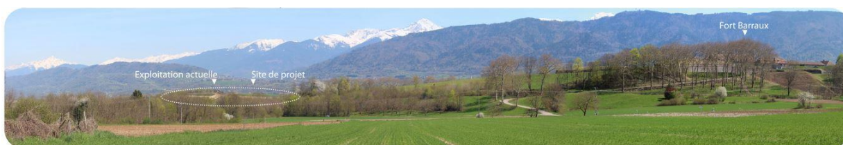
Terrain2 / 3. Depuis le village de Barraux
