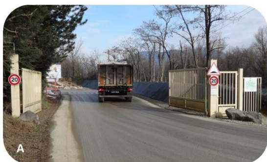
Illustrations de mesures visant à réduire les émissions sonores issues du site de Barraux. De gauche à droite : (A) Limitation de la vitesse de circulation à 20 km/h sur le site ; (B) Bardage de l'installation de traitement présente sur le site. Photo : 2015 - Granulats VICAT.
