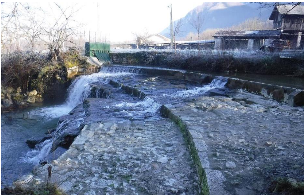
Figure 1 : Seuil Barrillonnière, ou seuil "Depagne" vue depuis la rive gauche. Janvier 2020. SYMBHI.
