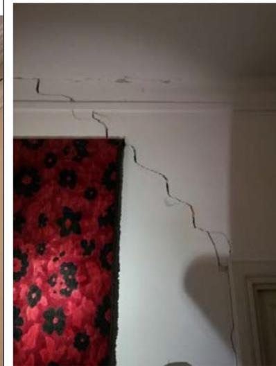
Fissure en échelon dans une cloison en briques
