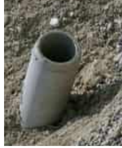
>> Buse sous la voirie inutilisable par la faune dans le sens de la remontée.
