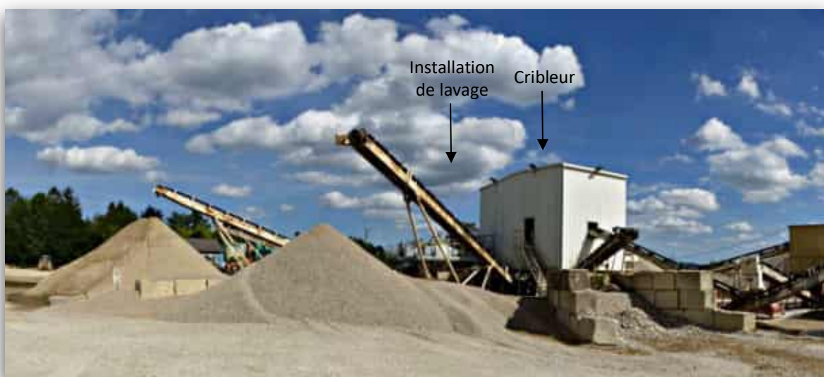
Installation fixe de traitement
