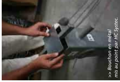
>> Filets anti-éboulements avec poteaux creux bouchés avec déchets plastiques.
