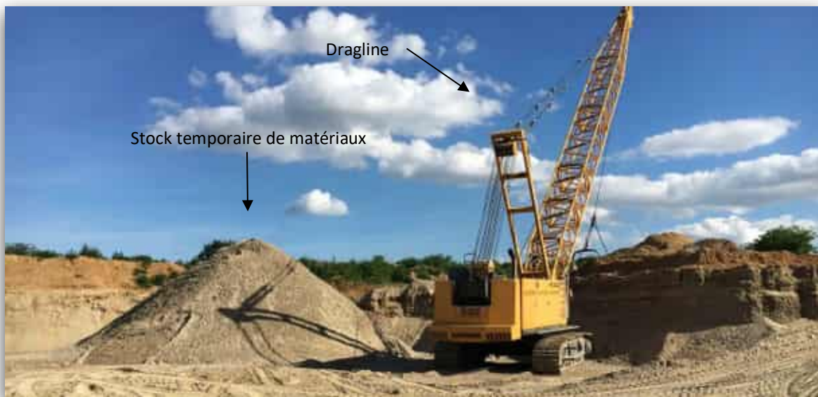
Dragline et stocks de matériaux en égouttage
