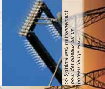
>> Système anti stationnement sur un pylône pour les oiseaux.
