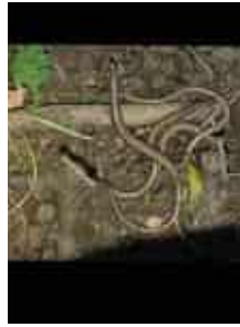
>> 5 orvets dont 3 morts dans un regard de compteur d'eau.
