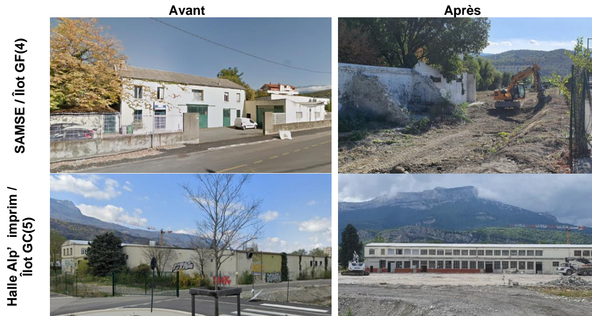
Figure 2 : Photographies des principaux bâtiments démolis
