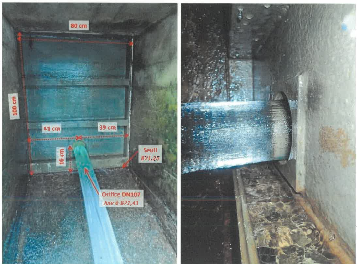
Photos de l'ajutage sur la vanne de chasse
