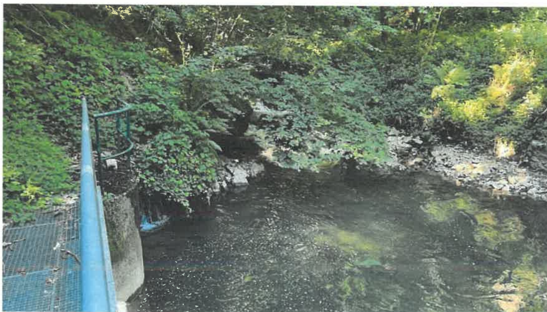
Photographie de l'amont de la prise d'eau.
