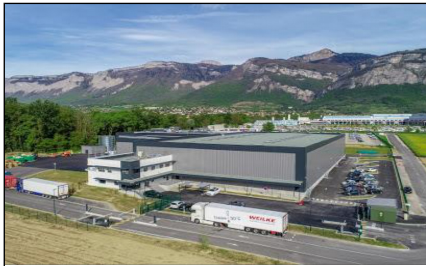
Vue aérienne d'ECTRA à Crolles
