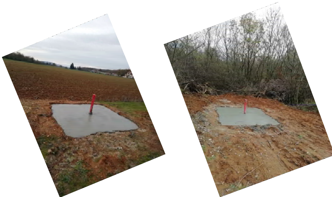
Photos Pz4 et Pz5 (source : Carrières PERRIN)
