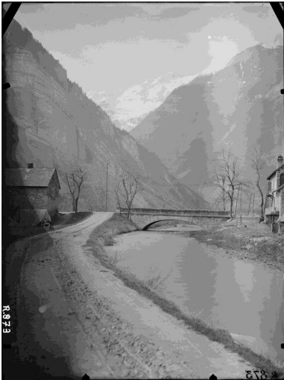
Photo de gauche : La Lignarre en avril 1914 en aval du pont de la RN 91 (archives RTM). On notera le fort alluvionnement du lit comparé à la période actuelle (photo de droite : 2 à 3 m d'incision formant un lit mineur dans la partie endiguée, et une risberme intermédiaire).
