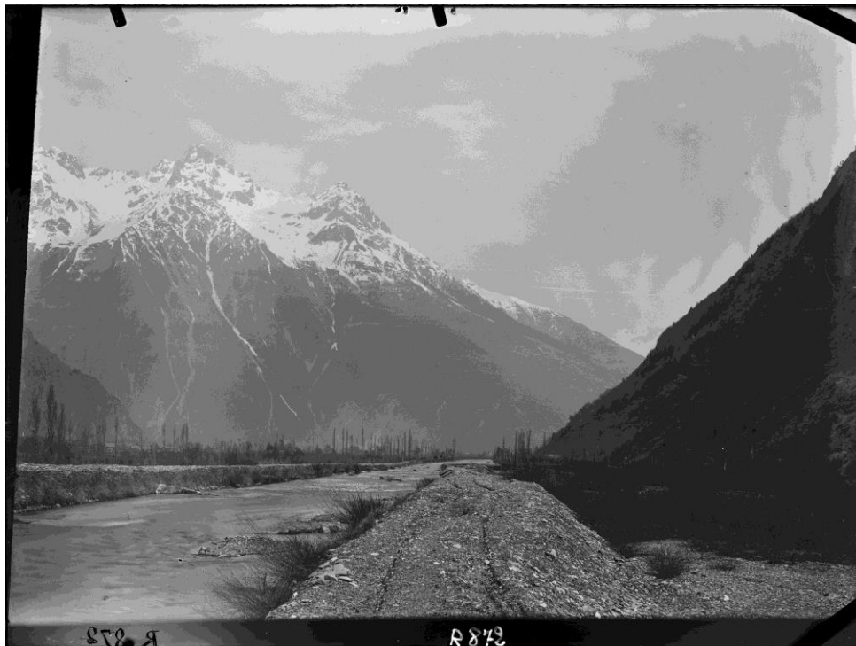
La Lignarre en amont de la confluence avec la Romanche, en 1914 (archives RTM). Ancienne plage de sédimentation en rive droite, comblée de matériaux alluviaux, avec digue récente la déconnectant du lit mineur canalisé.
