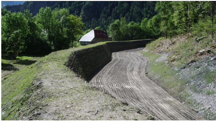
Merlon de protection pare-blocs en 2011 et écrans pare-pierres en 2010
