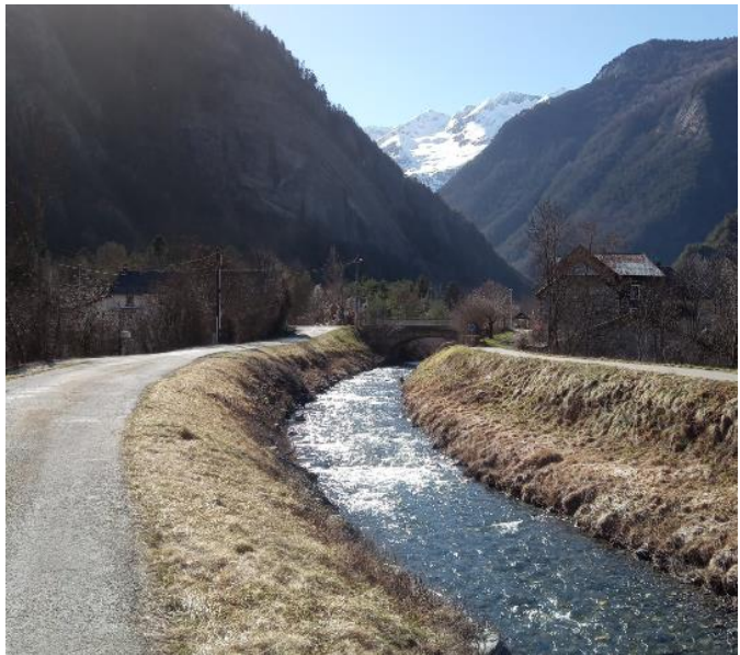
Photo de gauche : La Lignarre en avril 1914 en aval du pont de la RN 91 (archives RTM). On notera le fort alluvionnement du lit comparé à la période actuelle (photo de droite : 2 à 3 m d'incision formant un lit mineur dans la partie endiguée, et une risberme intermédiaire).
