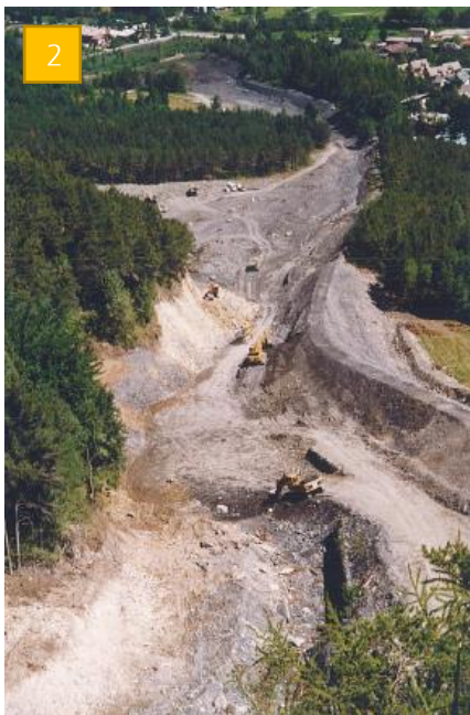
Construction des ouvrages de protection (1999-2001) : merlon pare-bloc (1), merlon pare-bloc et digue torrentielle/avalanche (2). Etat après construction (3) et en 2018 (4)
