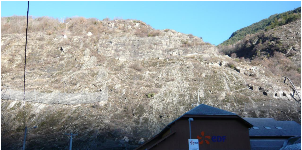
Ecrans de filets pare-blocs au-dessus de la centrale hydroélectrique et de la route d'Huez
