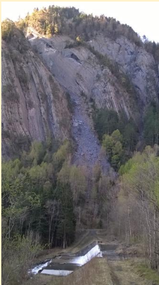
17 aout 2018 Les Gauchoirs. Chute de plusieurs blocs dont un de 2,5m 3 , arrivé à proximité des habitations.
