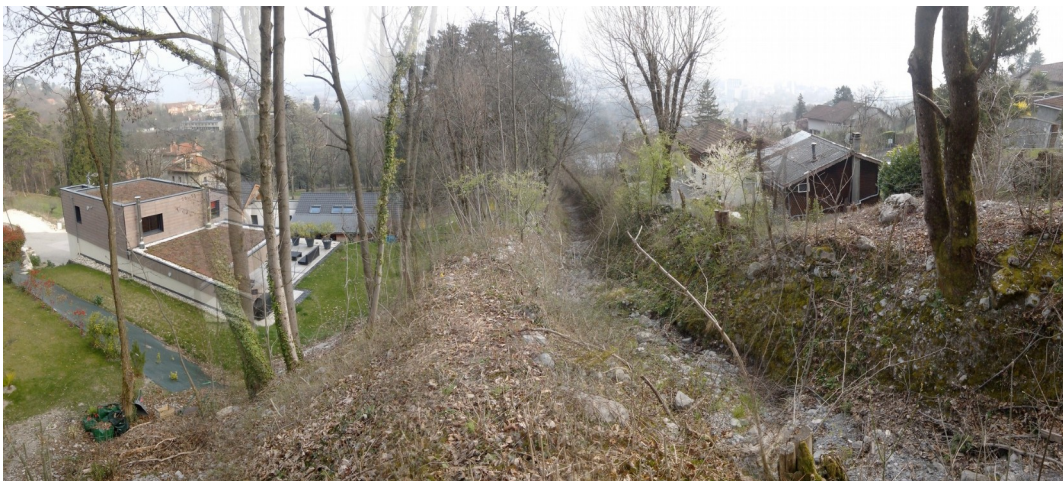
Illustration 10 : section perchée du torrent de la Ruine à l'aval du chemin de Maubec
