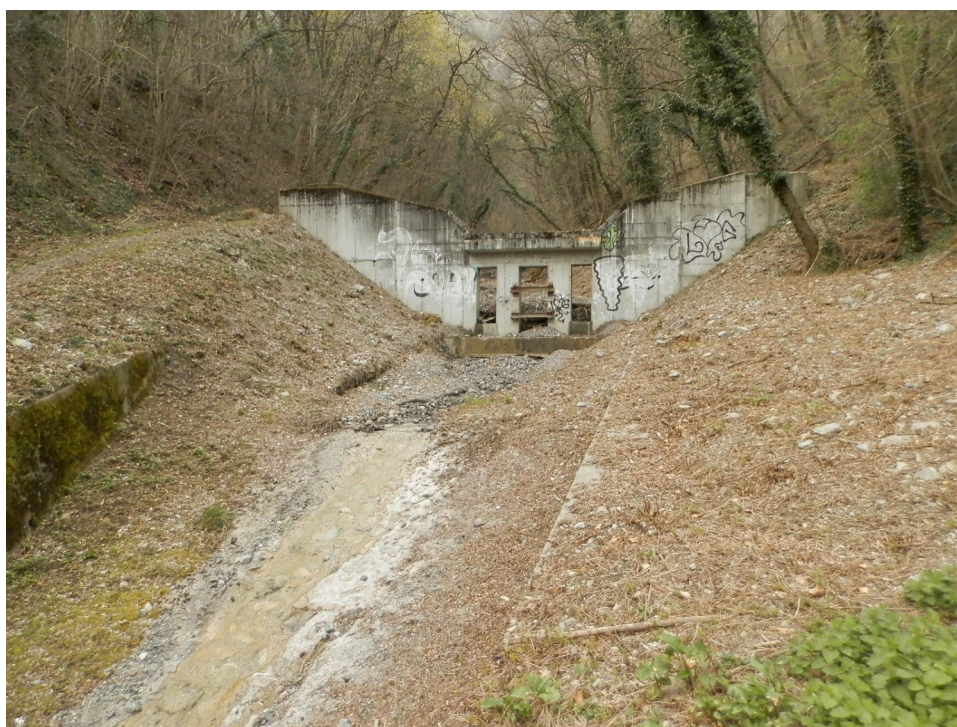
Illustration 9 : la plage de dépôt vue depuis le chemin de Maubec
