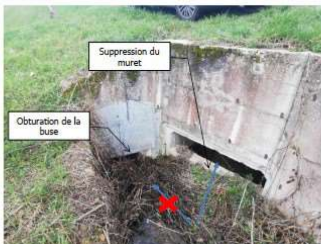
Figure 9 : Suppression de l'obturation partielle du cadre existant sous la RD67 (face amont)
