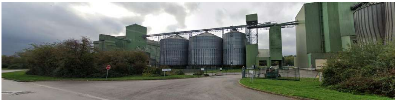
Photographie de loin face à la zone projet prise le 2 octobre 2019 (ci-dessus)
