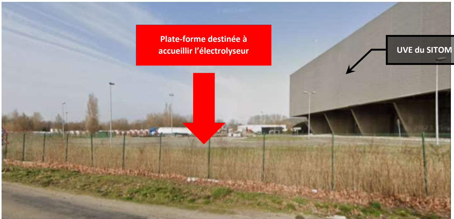
1. Site du projet vu depuis l'Avenue des Frères Lumières (prise de vue février 2021)
