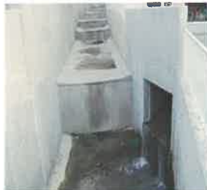
• 7. le Souchet canalisé (immeuble «les Chrysalides»)
