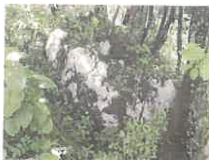
Bloc ancien éboulé : 2 m³ Amont du hameau de Ripaillère
