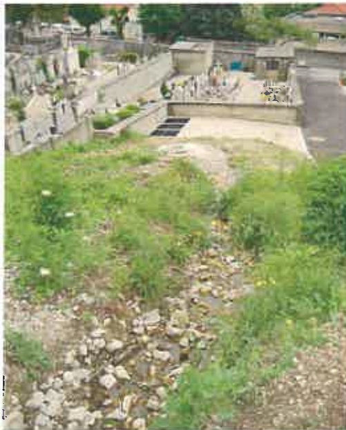
● 13. Fossé de collecte des eaux de sources au dessus du Cimetière.
