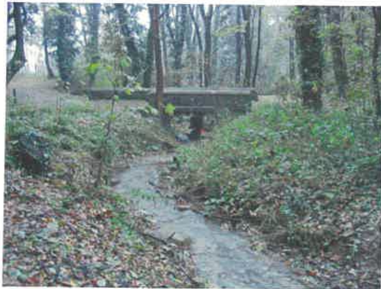
5. le ruisseau de GRAND MAISON en aval du pont du MOULIN (février 2005)
