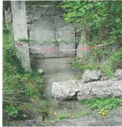
• 17. Ancienne galerie des Combes fonctionnant en émergence lors d'une crue.
