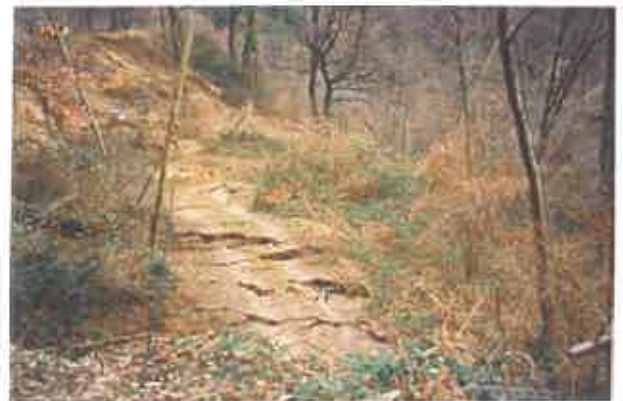
• 30. Glissement de janvier 1995 : Chemin du Canet détruit.
