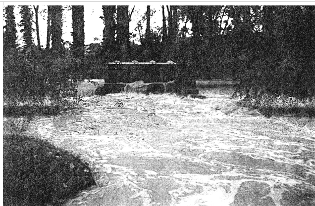
vannes et déversoir rue de l'Ozon
