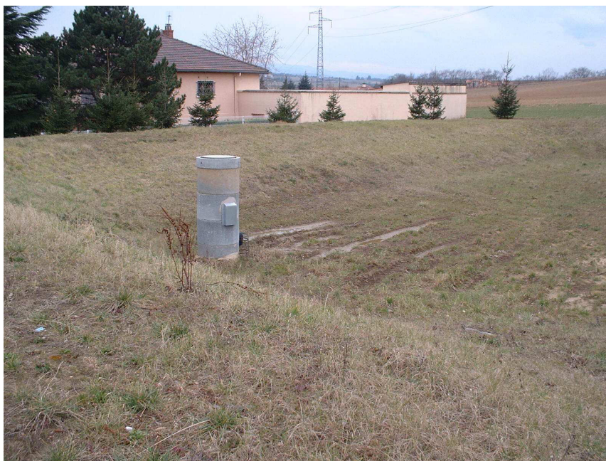
bassin de rétention Portes de Lyon – St-Symphorien d'Ozon
