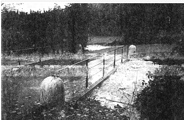
mise en charge du pont de l'Ozon
