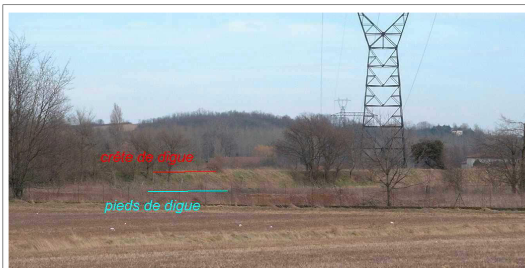
digues sur l'Ozon - Marennes
