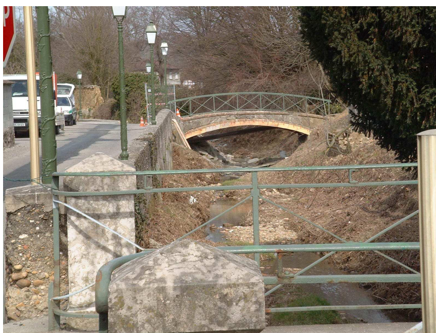
passerelle piétonne sur le ruisseau de Putaret - Chaponnay
