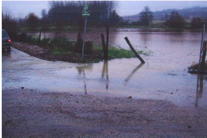
crue de novembre 2002 sur l'Inverse à Simandres – champ d'expansion en amont de la zone urbaine
