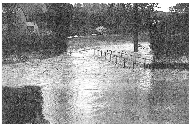
passerelle rue Philémon des Caillaux
