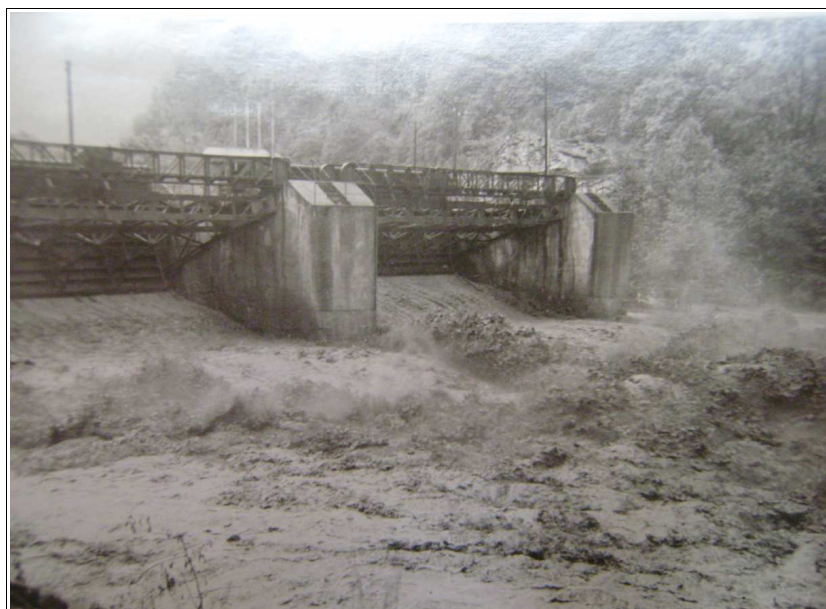
Photo 7 : Prise d'eau de Noyet-Chute. IGA - Fonds Pardé – Photographies et coupures de presse. La Romanche en cruë sort des vannes de la prise d'eau en aval de l'usine de Séchilienne le 15 Septembre 1940.
