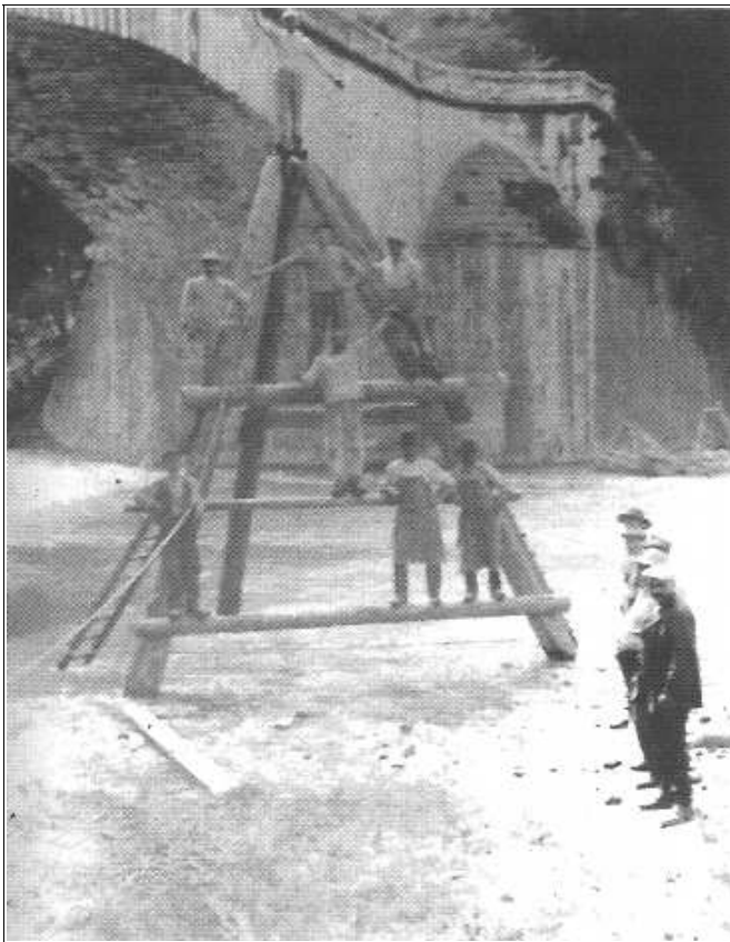
Photo 17 : Construction de cabrettes. « Vizille – Regards vers le passé » - Gérard MINGAT et Roger MORARD – 2003.
