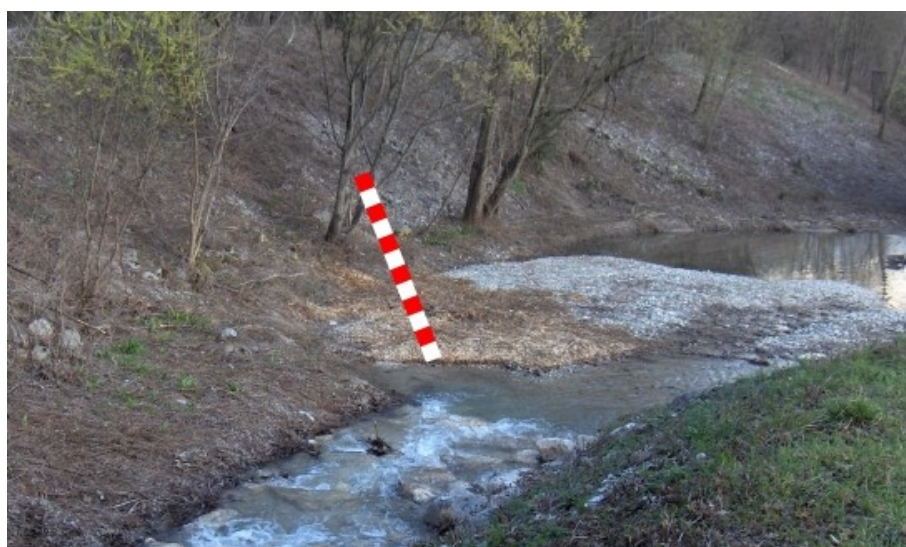
Illustration 2: Proposition (bureau d'études Hydrétudes) de localisation du repère d'intervention à l'amont de la plage de dépôts du ruisseau de Crolles.
