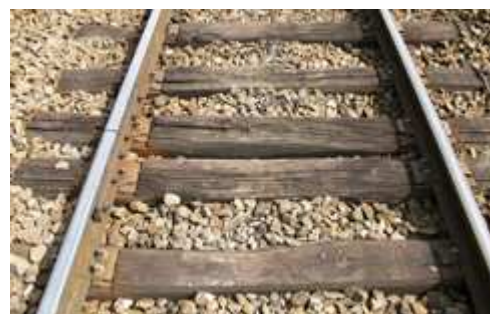
Rails courts sur traverses bois
