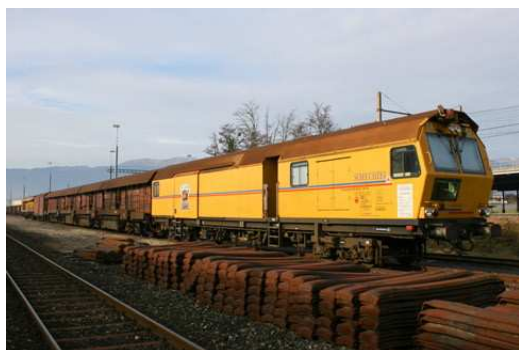
Train meuleur de rails (Scheuchzer S.A.)
