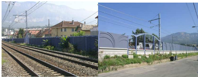
Exemples d'écrans acoustiques à Aix-les-Bains
