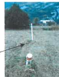
La Saulée La Petite Saône Pipeline
