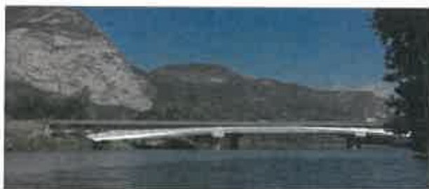
Figure 22 : Vue d'ensemble de la passerelle mode doux sur l'Isère à Rondeau.
