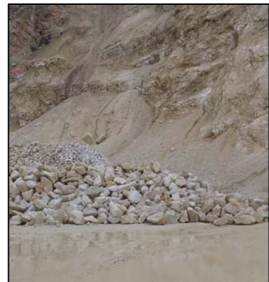
Flaques d'eau sur le carreau d'exploitation 4 jours après les précipitations.
