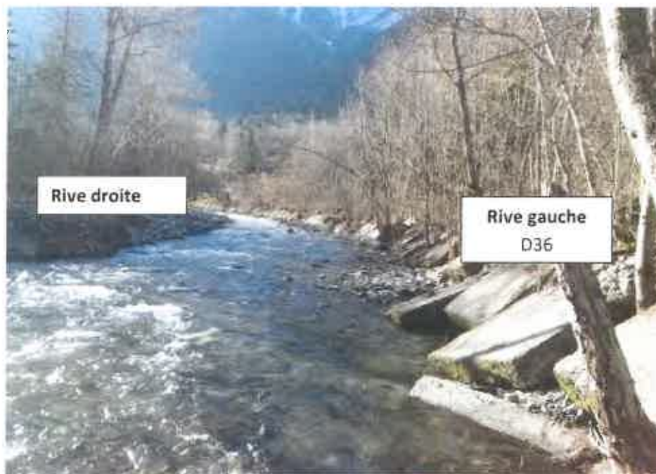
Figure n°1 - Berges de la Bonne au droit de Gragnolet - Digue D36 à conserver, rive droite à décaisser
