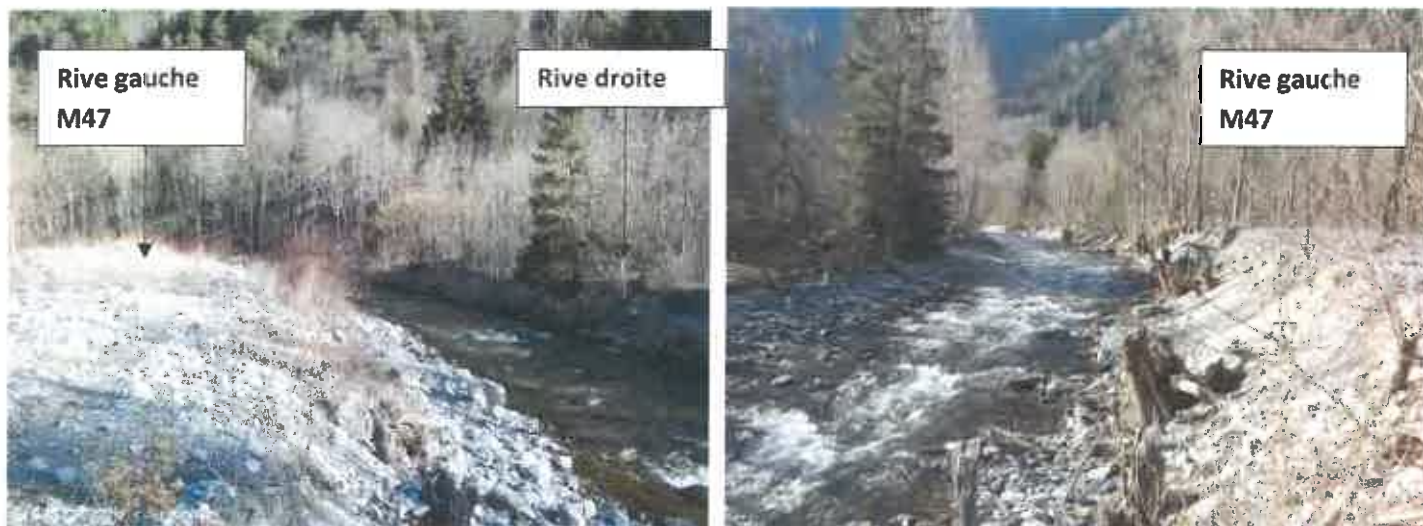
Figure n°3 - Berges de la Bonne au droit de Gragnolet - Merlon n° M47 à supprimer, rive droite à décaisser
