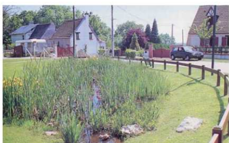
Noue engazonnée Opération Belbeuf – 76 Source Foncier Conseil
