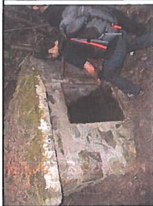
Photo 8 : Vue du bris-charge du Suchet, alimenté par les captages des Balmettes
