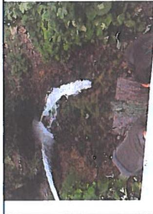
Photo 7 : Vue de la sortie du trop plein, captage n° 2 des Balmettes
