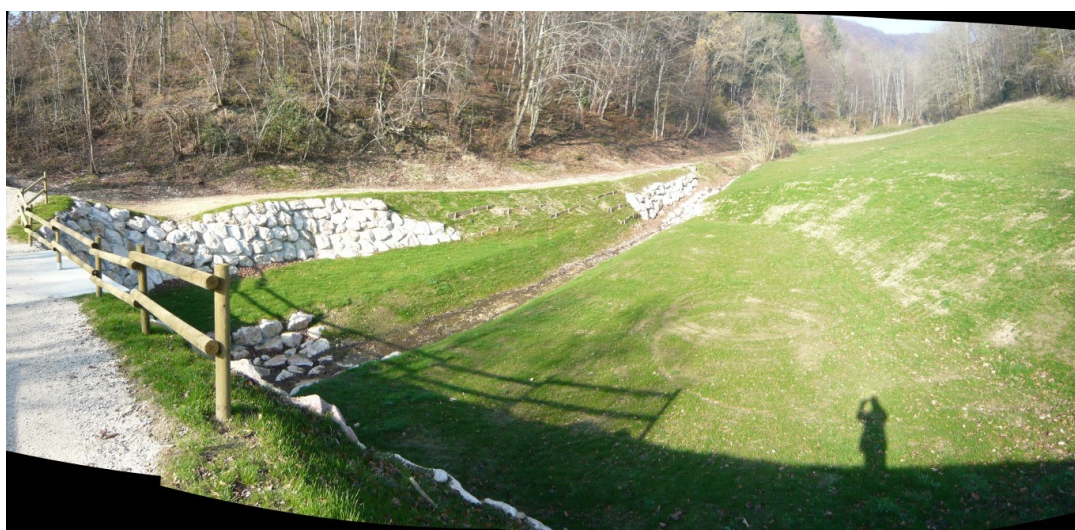
Illustration 6 : Plage de dépôt du torrent de la Vécîère – Photo RTM 2011
