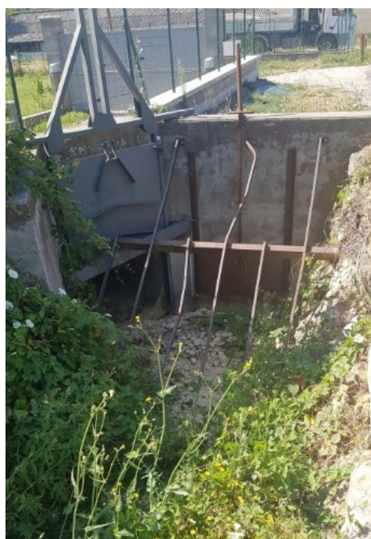
Illustration 9 : Grilles de la Vécrière en amont du bassin décanteur - Photographie AGC juillet 2019
