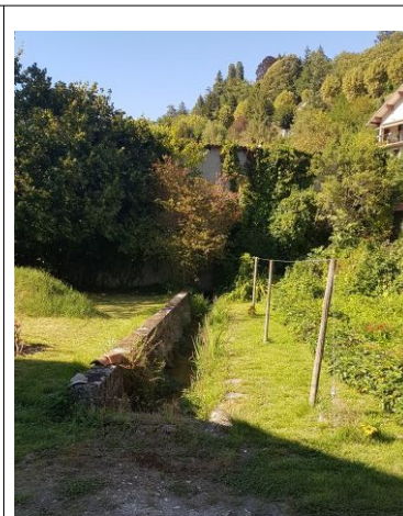
Illustration 45 : Ruisseau du Gorgeat en amont de l'ouvrage Ø500 mm - Photographie AGC juillet 2019
