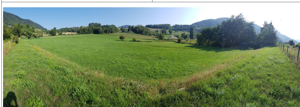
Illustration 27 : Bassin de rétention des Blanchisseries - Photographie AGC juillet 2019
