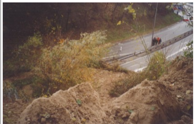
Illustration 44 : Glissement sur la RD75, 17/11/2002 - Photographie RTM
