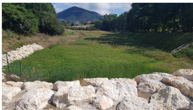
Illustration 35 : Bassins de rétention du vallon de Montponçon - Photographie AGC juillet 2019
