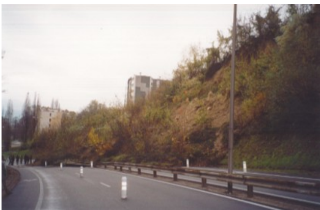
Illustration 43 : Glissement sur la RD75, 17/11/2002 - Photographie RTM
