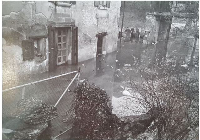
Illustration 32 : Inondations du vallon de Montponçon, décembre 1991 - Photographie d'un riverain
