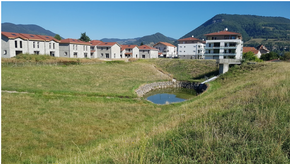
Illustration 37 : Bassin de rétention de la Tour de Criel - Photographie AGC juillet 2019
