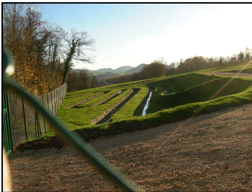
Le fossé de dissipation en fin de traitement après les étages de lits à macrophytes
