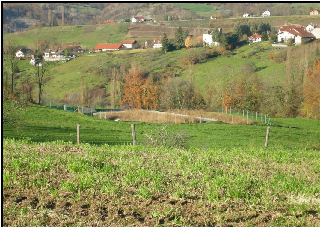
Station réalisée en pente, avec un impact visuel restreint
