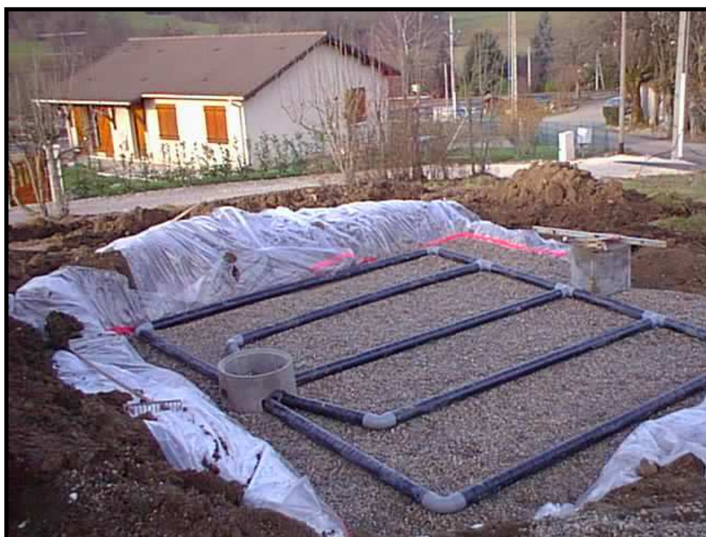
Filtre à sable vertical drainé étanche en cours de réalisation
