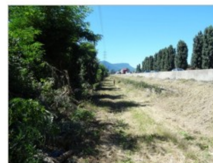
Vue de la piste d'entretien au droit du seuil de l'ILL. En haut : vue vers le sud. En bas : vue vers le nord.
