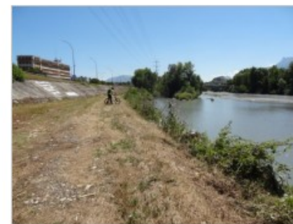
Milieux ouverts au droit de l'échangeur du Vercors. En haut : vue vers le nord. En bas : vue vers le sud (© Egis / D. Ferreira)
