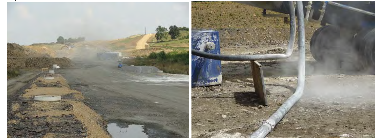
Figure 277 : Photographies d'envols de poussières sur chantier (© Egis / D. Ferreira)
