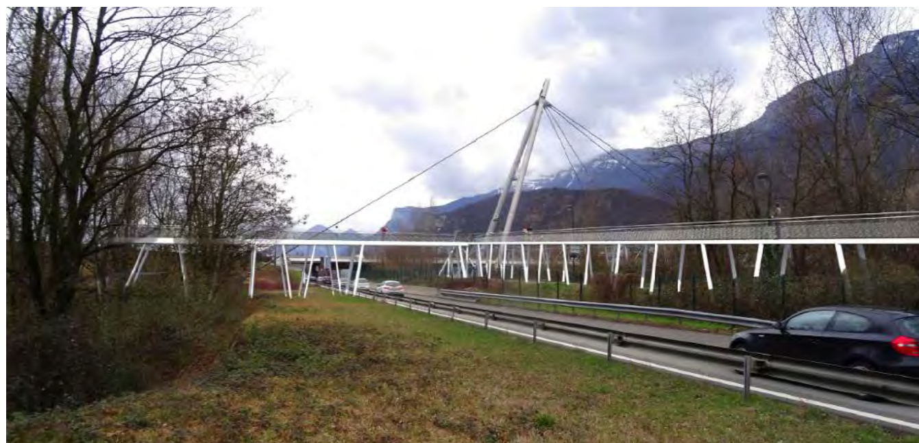
Figure 380 : Passerelle au dessus de la bretelle A480N vers RN87 : Vue depuis la bretelle en direction du Sud
