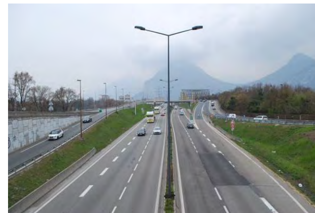
Figure 232 : Massifs de la Chartreuse et lampadaires vus depuis l'échangeur Catane
