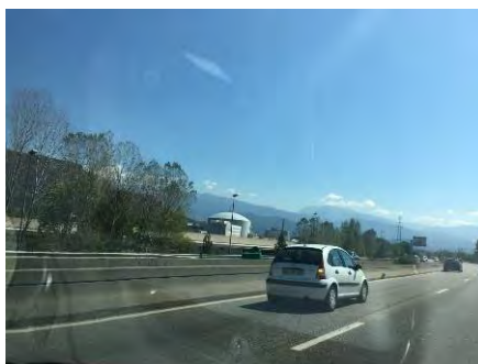
Figure 230 : A480 au niveau du Synchrotron (Ingerop)
