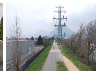
Figure 223 : Digue du Drac et pylône électrique (Ingerop)
