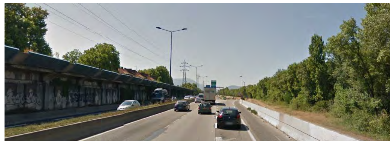
Figure 234 : Mur anti-bruit le long de la cité Mistral vue depuis l'A480
