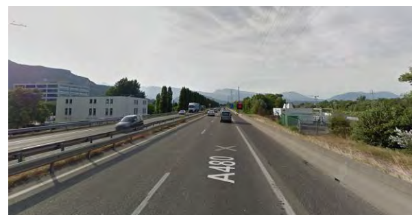
Figure 231 : A480 au niveau de l'institut LAUE Langevin et d'un ouvrage hydraulique sur le Drac (GoogleStreetView)
