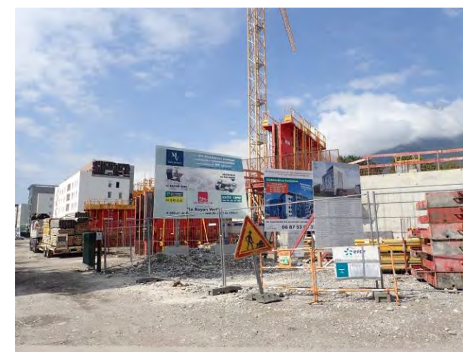
Photographie 201 : Chantier Navis en cours au Sud-Est du Rondeau
