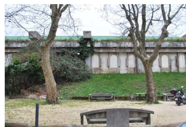
Figure 235 : Mur anti-bruit vue depuis la cité Mistral
