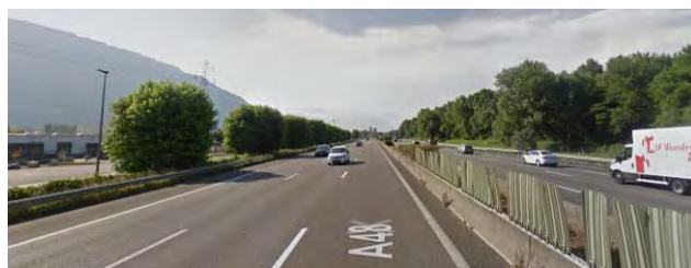
Figure 228 : Zone d'activité de Saint-Égrève vue depuis l'autoroute (GoogleStreetView)
