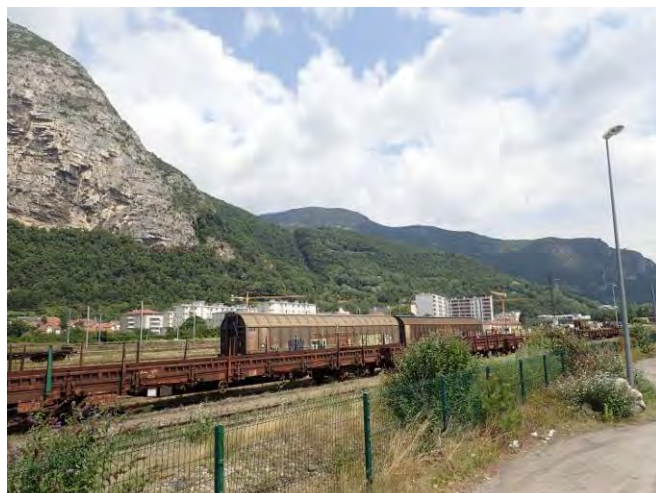
Figure 209 : Photographie de la plate-forme multimodale à Saint-Martin-le-Vinoux
