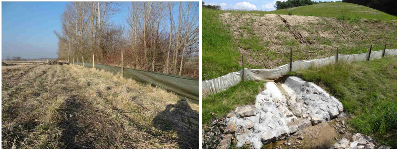
Figure 135 : Exemples de dispositifs en limite d'emprise (© Egis / D. Ferreira)
