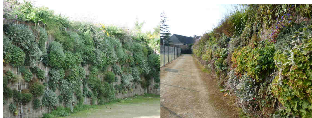
Figure 140 : Photographies de murs végétalisés à vocation acoustique en milieu urbain (© http://www.liaisonvegetale.com )
