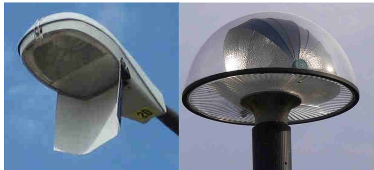
Figure 144 : Illustration des adaptations sur les lampadaires : boucliers à gauche, lampadaire boule avec capot réflecteur à droite ( http://www.biodiversite-positive.fr/ )
