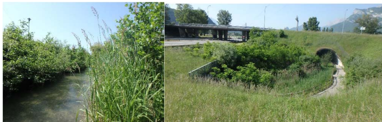
Photographie 52 : Lavanchon et de son rétablissement dans l'échangeur de Pont-de-Claix (© Evinerude)
