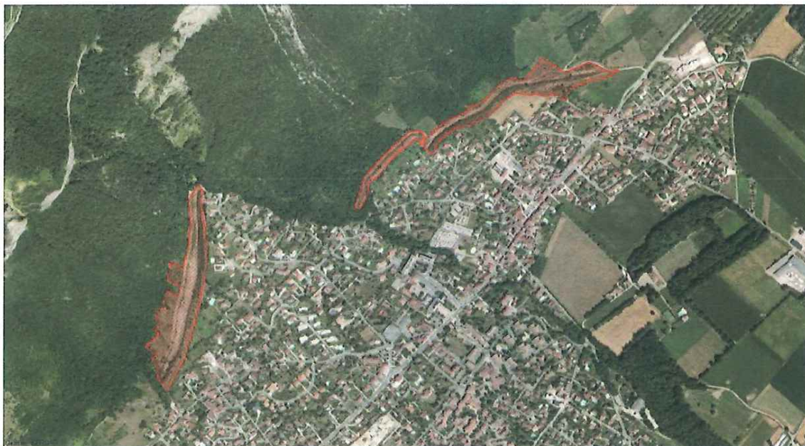
Ouvrages existants dont la gestion sera adaptée aux enjeux écologiques
