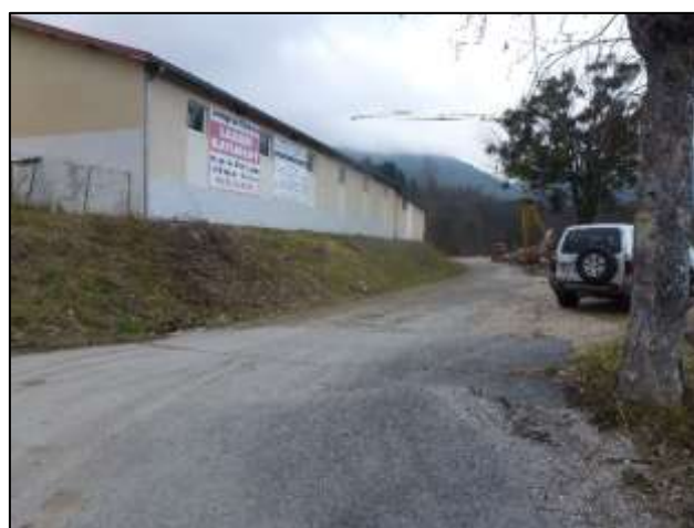
Ancienne route le long du bâtiment
