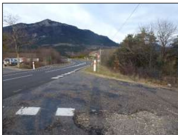
Voie d'accès à droite en contre-bas
