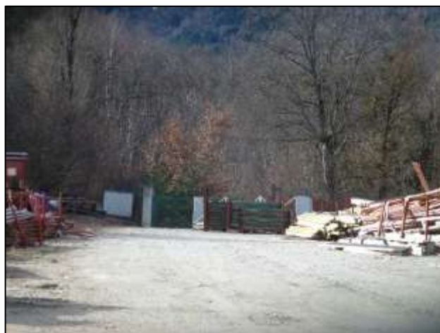
Portail d'accès à l'arrière du bâtiment
