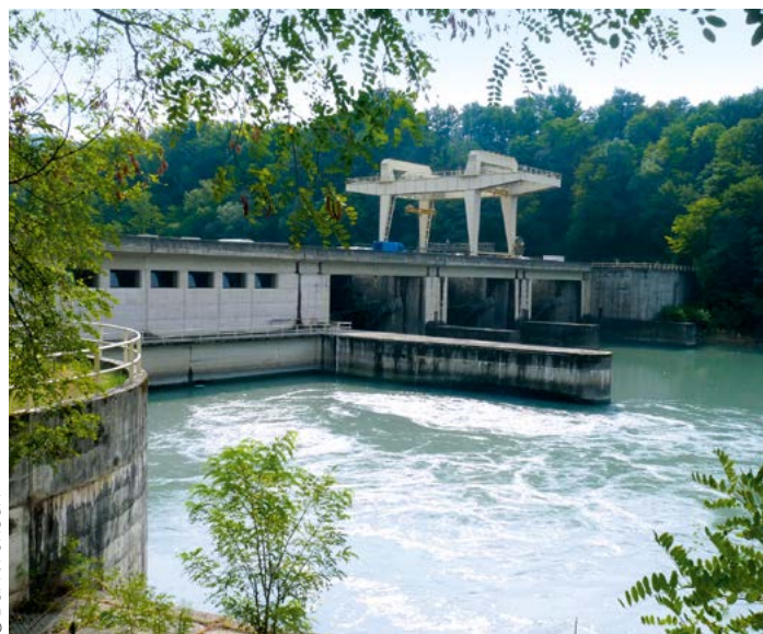
Barrage de Beauvoir – Commune de Saint-Romans
