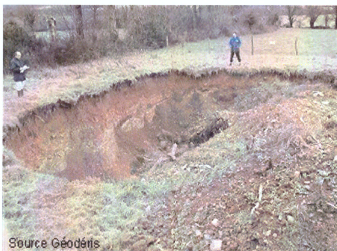
Photo 1 : fontis en zone non urbaine
