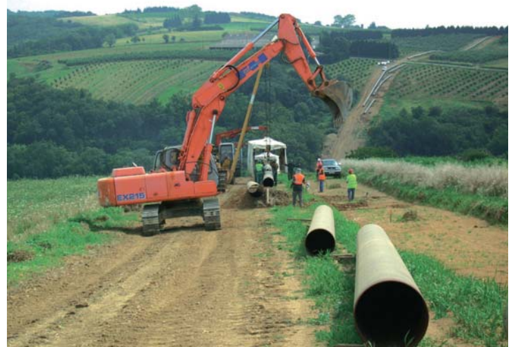
Pose de la canalisation de gaz Serpaize-Les Haies - Photo DRIRE
